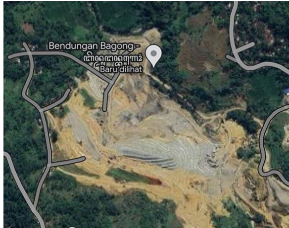
Gambar 3. 1 Proyek Bendungan Bagong Tahap II
