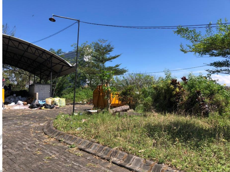
Gambar 1. 1 Tidak adanya fasilitas yang lengkap dan terpadu pada kawasan TPS kampus III Universitas Muhammadiyah Malang
