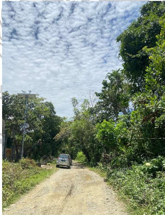
Gambar 1. 2 Kondisi Ruas Jalan Desa Watu
