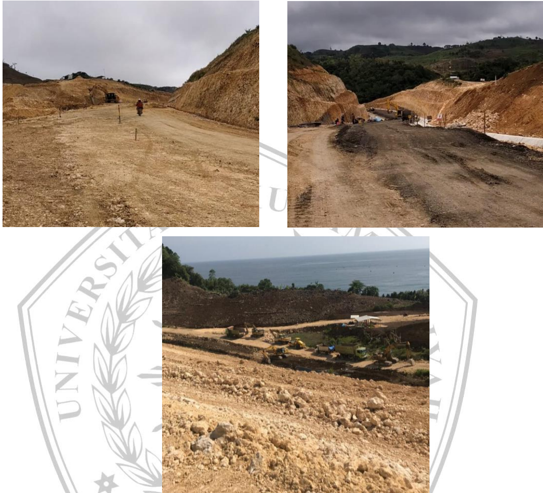
Gambar 1.2 Kondisi Lahan Jalan
