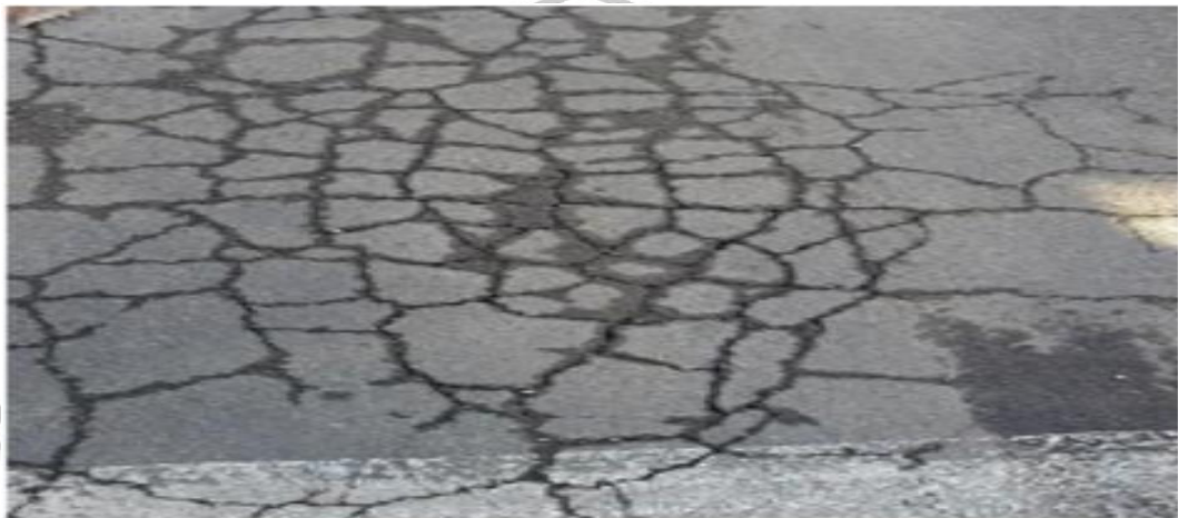
Gambar 2.2 Retak Kulit Buaya
