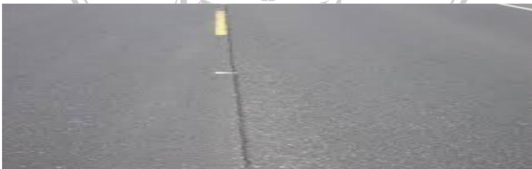
Gambar 2.9 Retak Sambung
