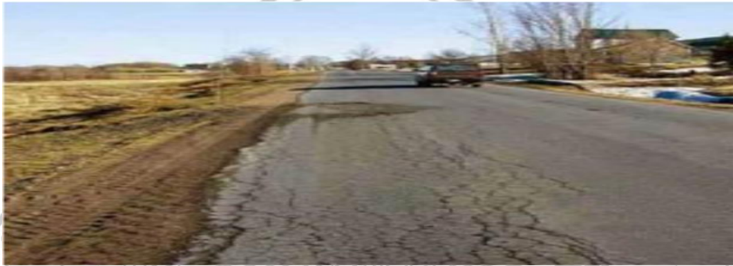
Gambar 2.8 Retak Pinggir
