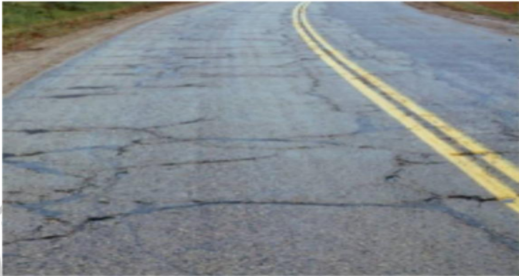
Gambar 2.4 Retak kotak-kotak
