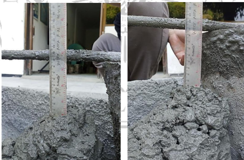
Gambar 4.1 Uji Slump Benda Uji Silinder
