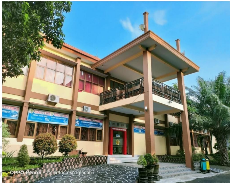
Gedung Kantor Utama SMK Negeri 1 Glagah
