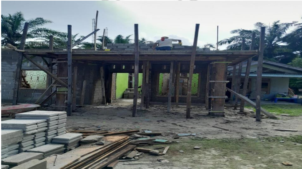
Gambar 4.7 Rumah Yang Sedang Di Kerjakan Oleh Bapak S
