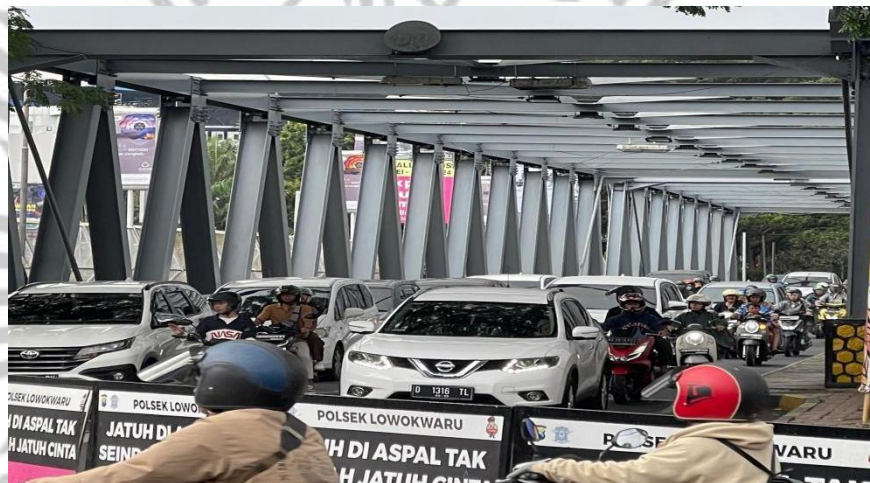
Gambar 1.3 Tampak Jembatan pada kondisi jenuh/macet pada tanggal 1/06/2024.
