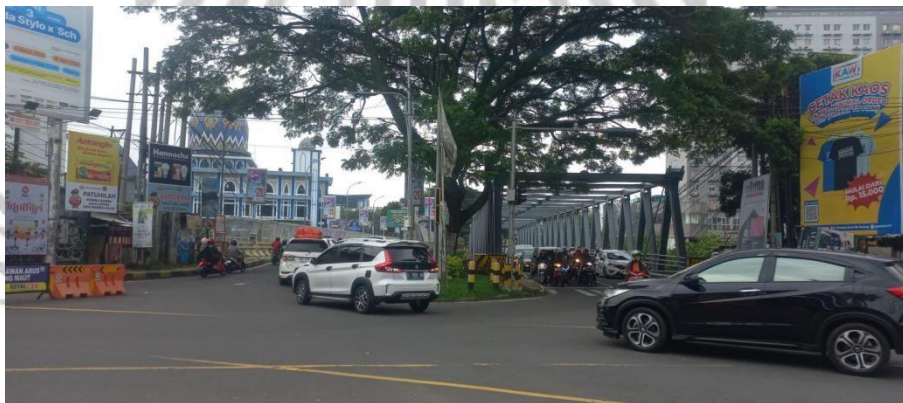
Gambar 1.1 Tampak Jembatan Sisi Depan pada tanggal 9/04/2024.
