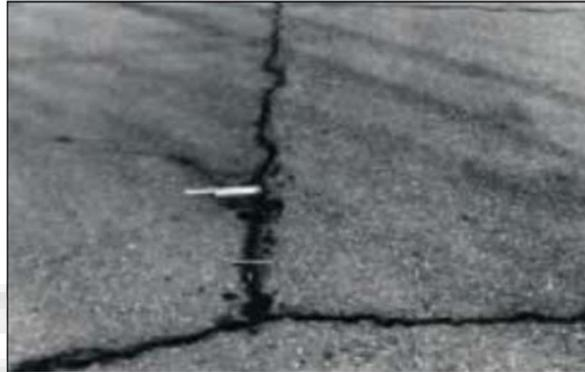
Gambar 2. 15 Retak Refleksi (*Reflection Cracking*)
