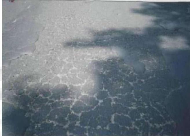
Gambar 2. 23 Pelepasan Butir (*Ravelling*)
