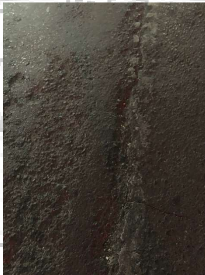
Gambar 1. 3 Retak Memanjang
