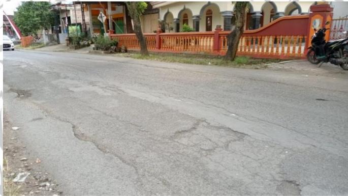
Gambar 1. 6 Kondisi eksisting Jalan Neyama Kecamatan Besuki Kabupaten Tulungagung yang mengalami Retak-retak (*Cracking*) dan Alur (*Ruting*), 6 Agustus 2023
