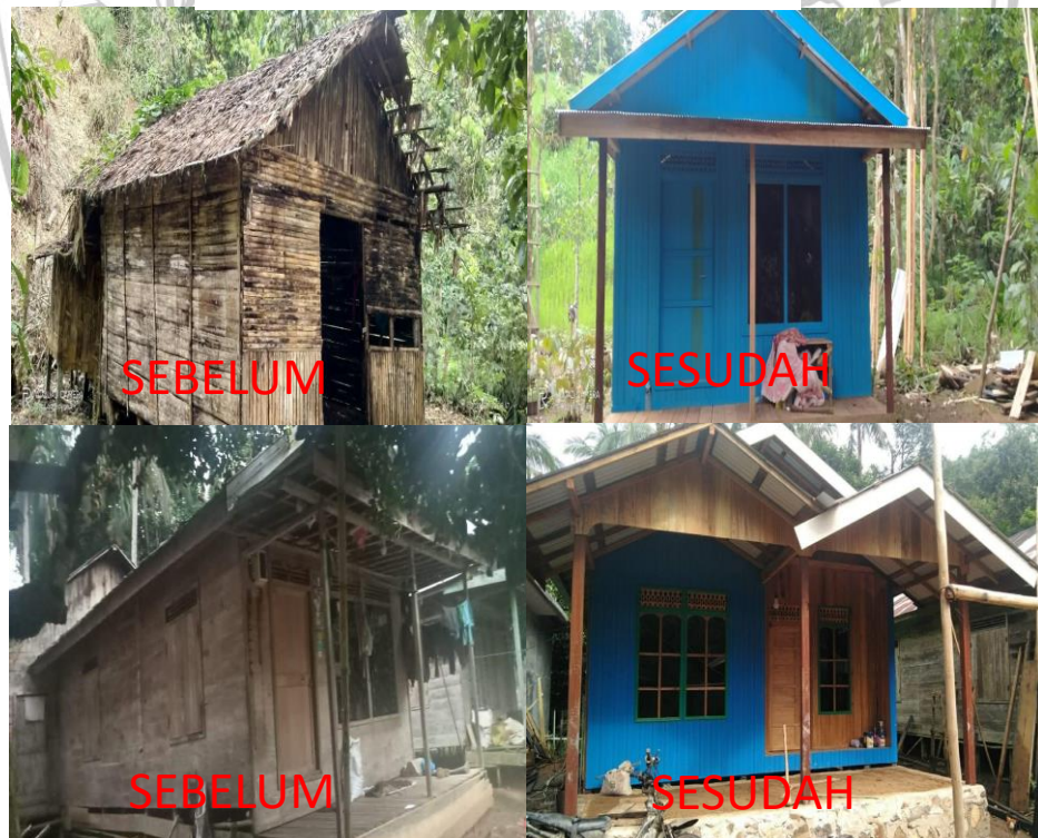
Gambar 4.3 Perbaikan Rumah Warga
