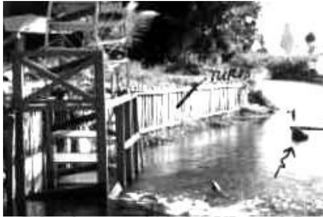
Gambar 2. 8. Contoh pelindung tebing dari turap kayu
