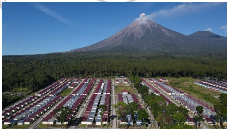
Gambar 4.3. 21 Total pembangunan hunkap oleh MDMC berjumlah 200 unit. (Sumber: Nurita Noviandari, 2022)
