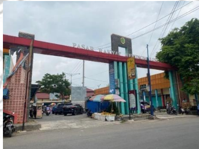
Gambar 1.tampak depan pasar tradisonal Kedungmaling
