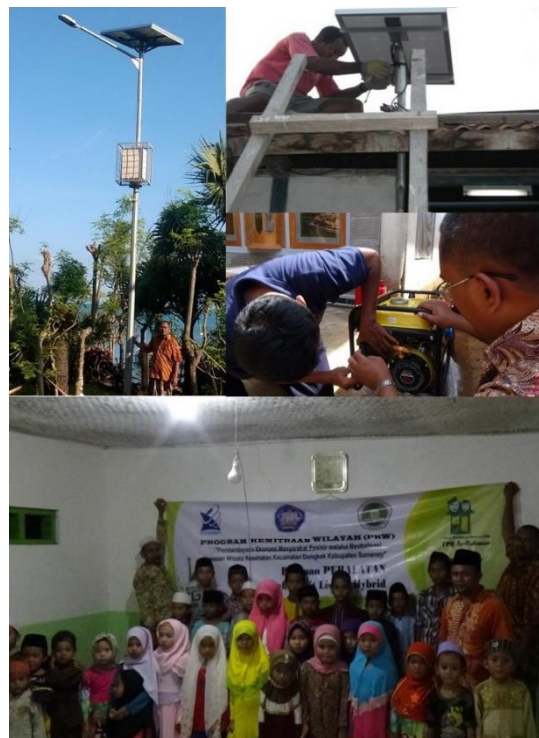
Gambar 8. Pemanfaatan PLTS hybrid genset sebagai sumber energi listrik
