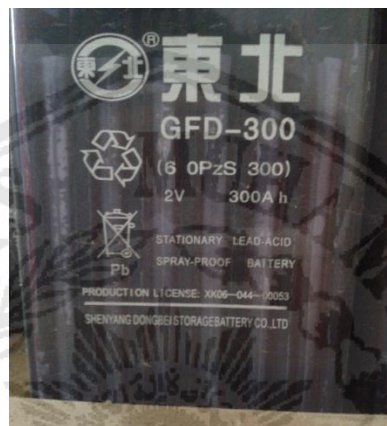
Gambar 3.4 Baterai PLTS Kalipucang
