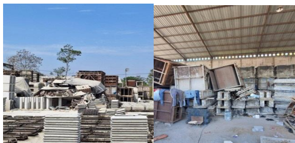
Gambar 1.1 Kondisi lingkungan kerja PT Jaya Etika Beton
