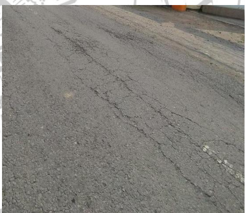
Gambar1.4 Retak Memanjang
