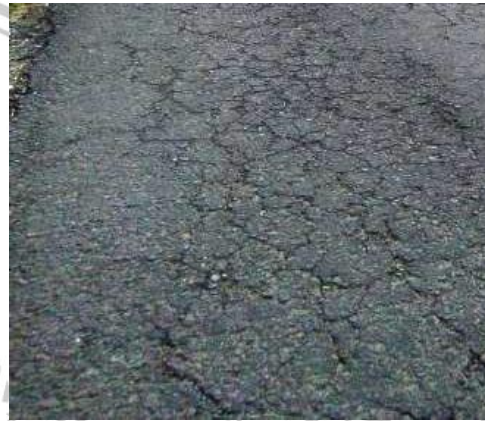
Gambar1.2 Retak Kulit Buaya
