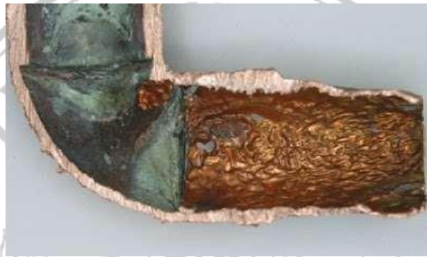
Gambar 2.2 Korosi Erosi pada Pipa
