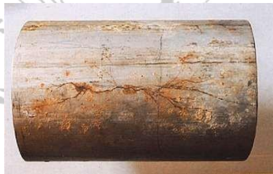
Gambar 2.1 Retakan Pada Pipa
